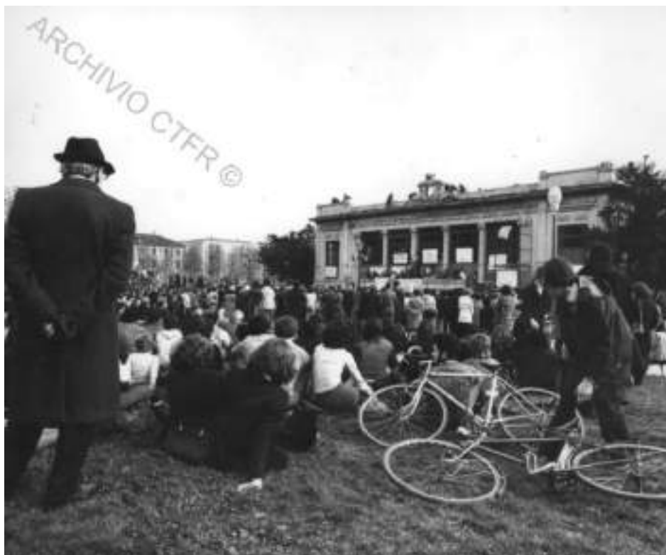
1974 - Fotografie in bianco e nero, alcune di Tiziano Alderighi, scattate durante la raccolta firme per l'occupazione della Palazzina Liberty e durante i lavori di ristrutturazione promossi da Dario Fo e Franca Rame. © Archivio Rame Fo – Fondazione Fo Rame
